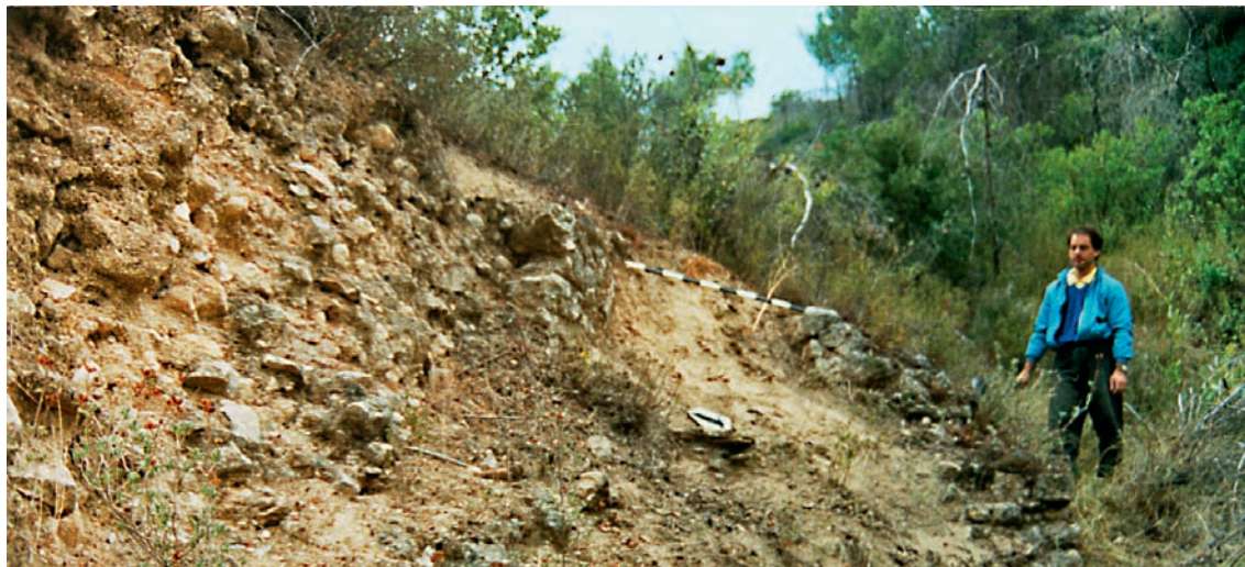
Η βάση και μέρος των πλευρικών τοιχωμάτων του αγωγού στις όχθες του Σμυρτορέματος Σπαθοβουνίου.
