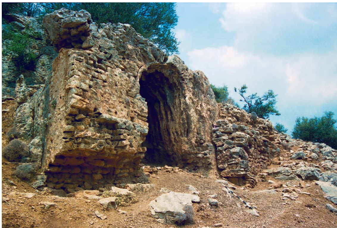
Τόξο στη Βελανιδιά Μεγαλοβουνίου με μεταγενέστερη αντηρίδα στο δεξί του βάθρο.
