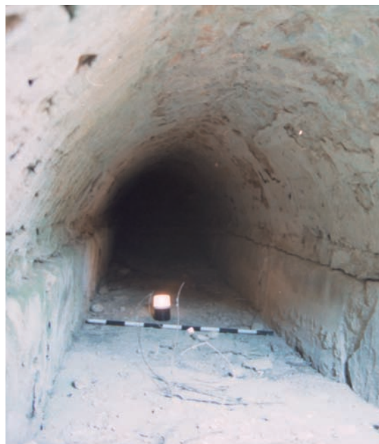
Ο υπόγειος αγωγός στη θέση Σταλιό, ανατολικά του Αγ. Βασιλείου.
