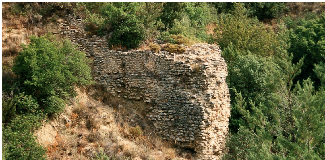
Βάθρο γέφυρας στο ρέμα Σκουρούκλη, μεταξύ Κουνταλά και Σπαθοβουνίου.
